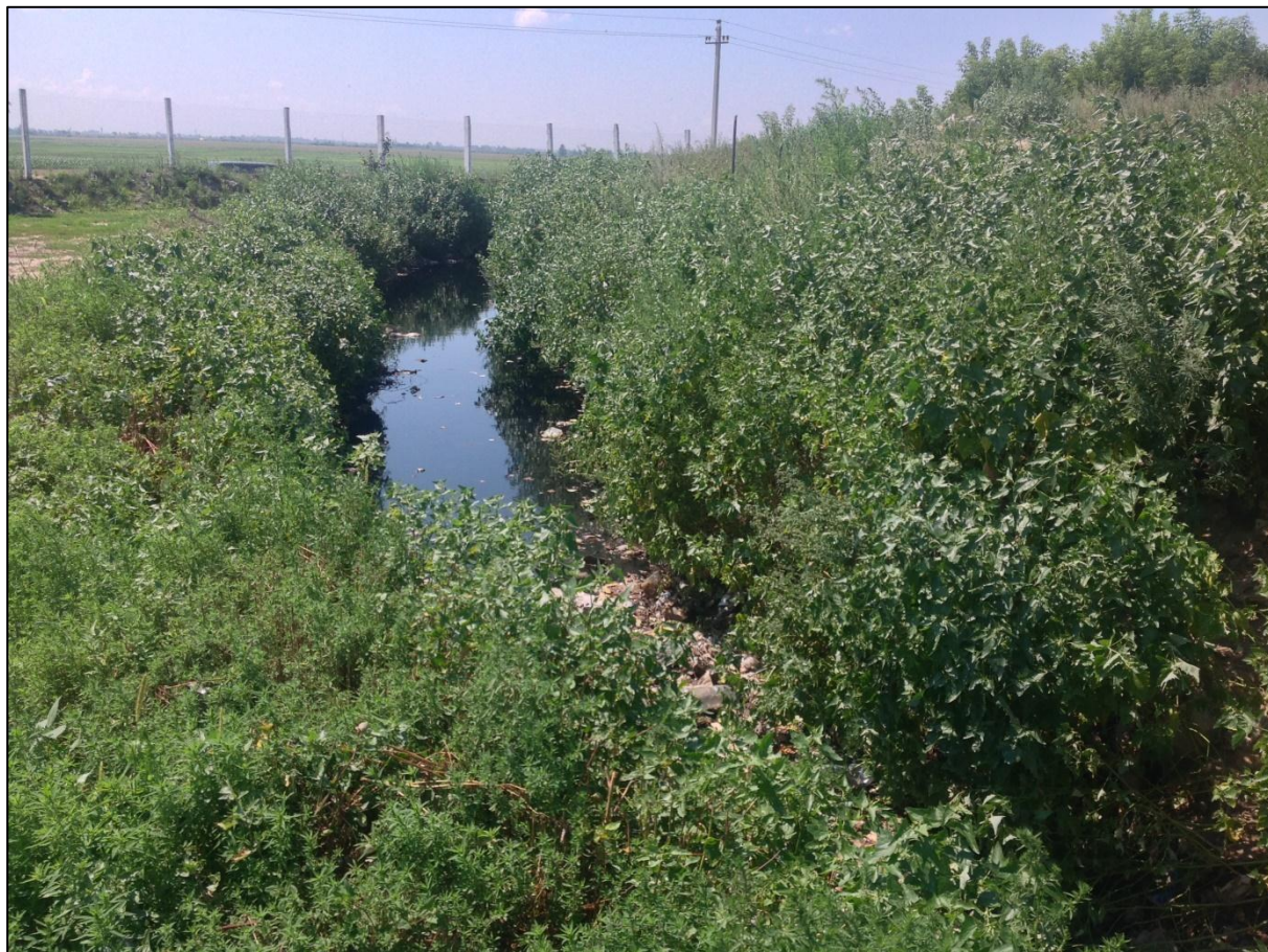
Рисунок 2 – Русло обводного канала на территории полигона ТКО г. Пинска недалеко от д. Вулька-Городищенская Пинского р-на Брестской обл.
